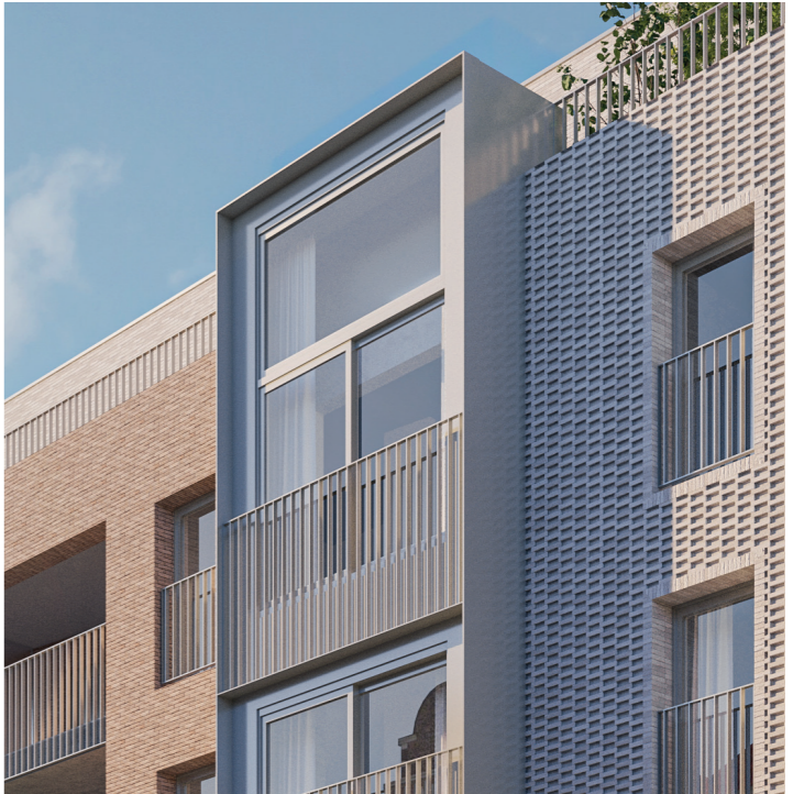
BOW-WINDOW Menuiserie en aluminium «métallisé chaud» Garde corps : barreaudage métallique finition idem menuiseries
