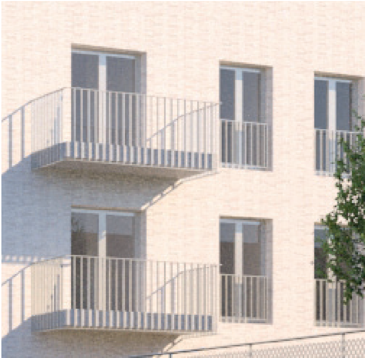
BALCONS MÉTALLIQUES Bacon avec garde corps : nez de dalle et barreaudage métalliques finition idem menuiseries. Détail sumilaire à ceux de la rue Léon Jouret.
