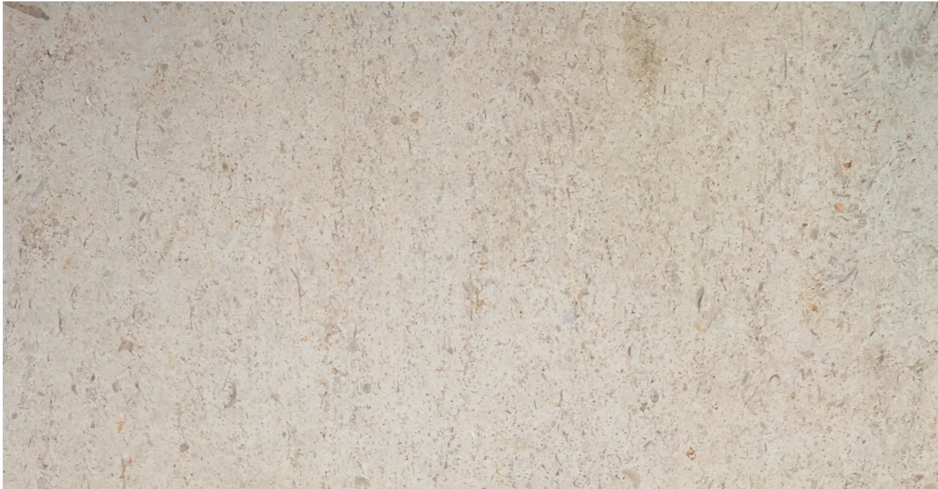
UNE FAÇADE DE STANDING EN PIERRE CLAIRE : Revêtement de façade en pierre agrafée naturelle, Pierre claire type Magny le Louvre (Bourgogne)
